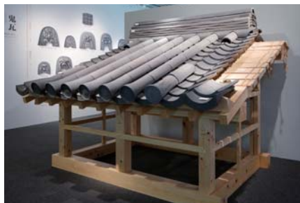
屋根の葺き方模型(現代と古代の葺き方)
