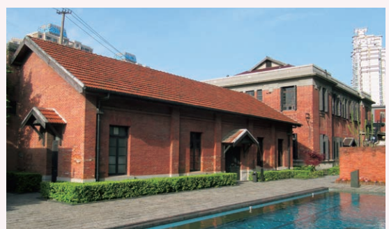
食堂棟(手前)と事務所棟(奥)
