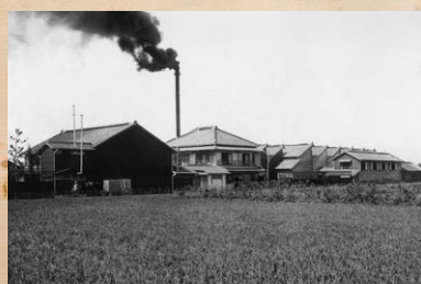
1912年完成の豊田自働織布工場
