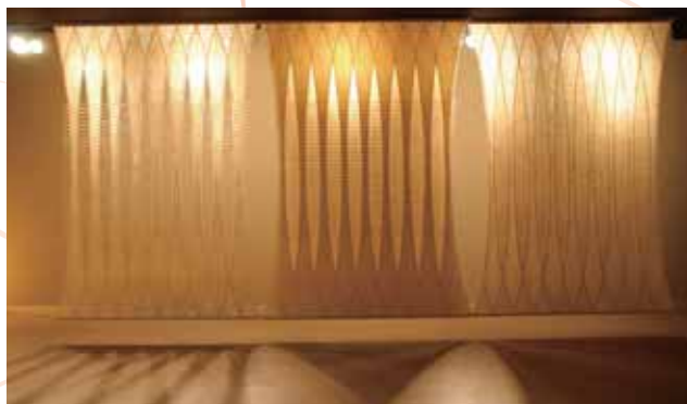
スライディング・ブラインド。重ね合わせて変化を楽しめる切り込み模様は、空調や自然の風が吹き抜ける「風の道」の工夫でもある。
