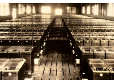
据え置き用の鉛蓄電池 Lead storage battery for floor putting 「一般社団法人 電池工業会提供」
