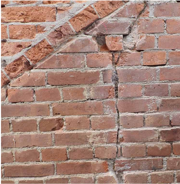
貫通していた亀裂部分は、液体と粘土状の2種類の石材用接着剤で修復
