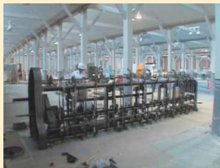
繊維機械館に紡機が運び込まれる。
