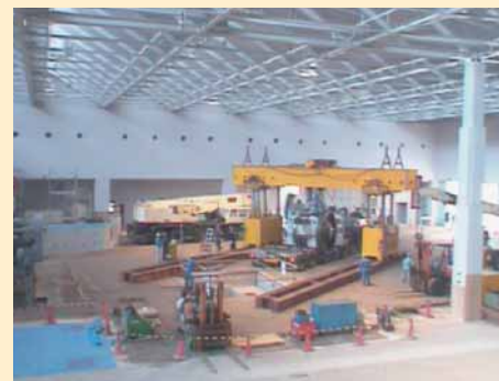
自動車館にも大型機械が設置される。
