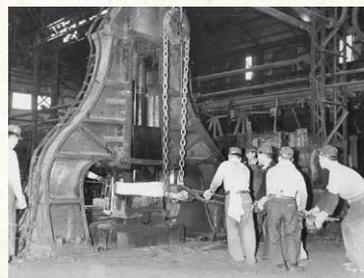
写真7 A型エンジンクランクシャフトの鍛造
