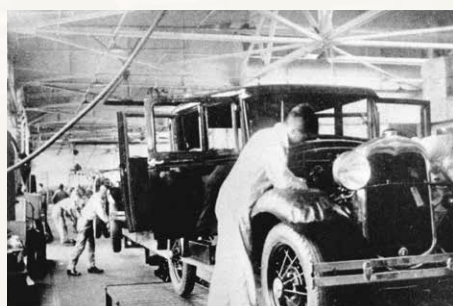
(写真4)フォード自動車 横浜のノックダウン工場
