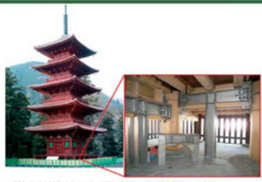
延性(粘り強さ)により五重塔の耐震補強に採用
