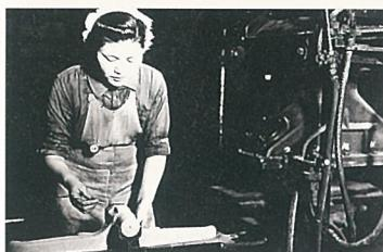
へらを用いた油砂製中子の造型作業。
